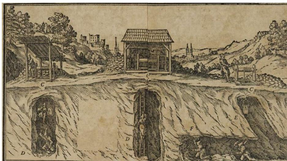
Рис. 21: Иллюстрация из издания: *Löhneysen G. E. Bericht Vom Bergkwerck, Wie man dieselben Bawen und in guten Wolstandt bringen soll, sampt allen dazu gehörigen Arbeiten, Ordnung und rechtlichen Proceß.* [Zellerfeldt], 1617. Между S. 12 и S. 13. С — Haspeln (крутить лебедку). D — Schacht fincken (копать шахту). E — Donleger Schacht (вертикальный шахтный ствол с горизонтальной штольной). F — Tragstöllen oder Wasserseig (штольня или желоб).
